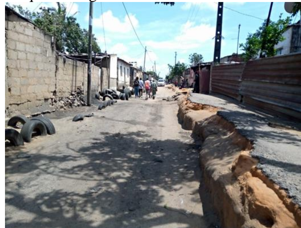
Figura 1: Erosão resultante das chuvas no bairro Inhagóia “A”, Osvaldo De Castro Matessane, 2023
