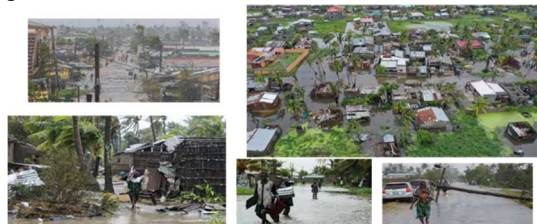
Figura 4: Danos causados pelo ciclone FREDDY na província da Zambézia.
